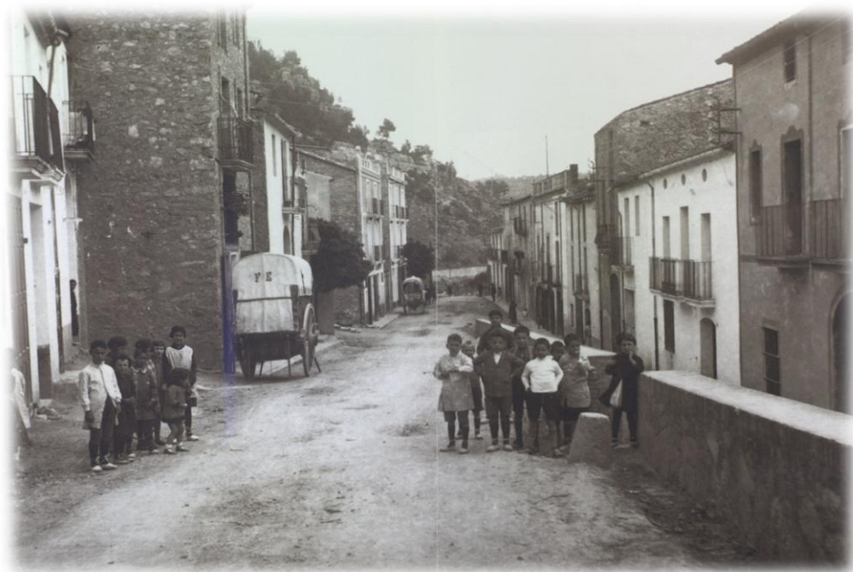
Foto A2. Vista de la Avenida Catalunya (Años 20 del siglo XX)
