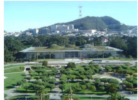
Se han diseñado las inclinaciones de las colinas, para generar corrientes de aire hacia el patio interior, permitiendo una adecuada ventilación, con lucernarios en su parte superior que permiten salir el aire caliente cuando es necesario.
