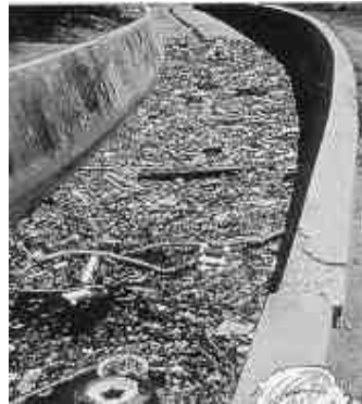
Fig. 2: Canal de hormigón: Sistema impermeable que magnifica la contaminación del agua
