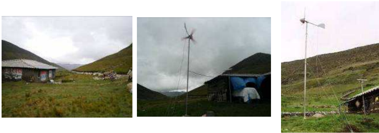
Figura 4.3 Vista general de la comunidad de Cerro Alto y de los aerogeneradores de 100W y paneles fotovoltaicos de 50W.
