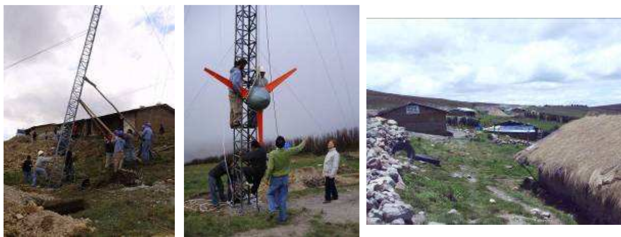
Figura 4.6 Instalación de aerogenerador de 500W en la comunidad de Alto Perú y vista general de la comunidad
