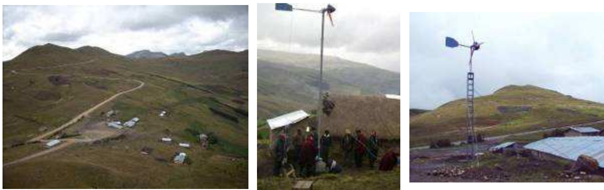
Figura 4.8 Vista general de la comunidad de El Alumbre y de los aerogeneradores de 100W y 500W instalados.
