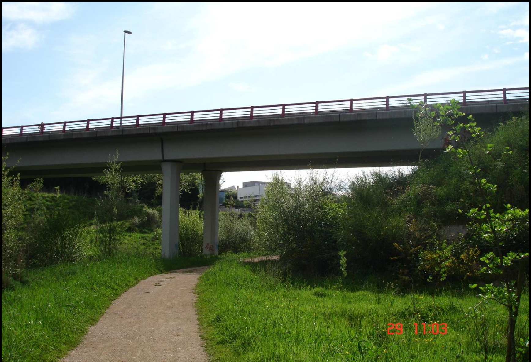
Puente de acceso a Cambre
