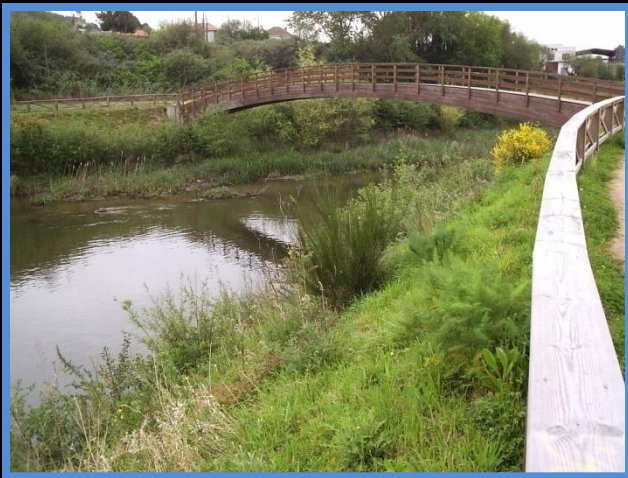
Puente sobre el río Mero
