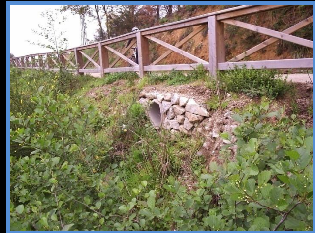
Obra drenaje transversal
