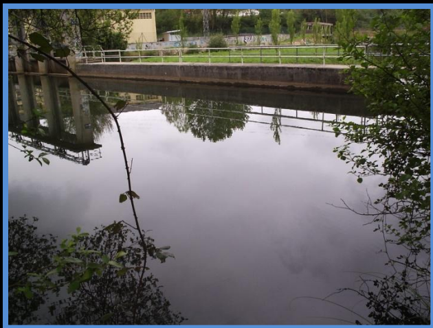
Muro de hormigon
