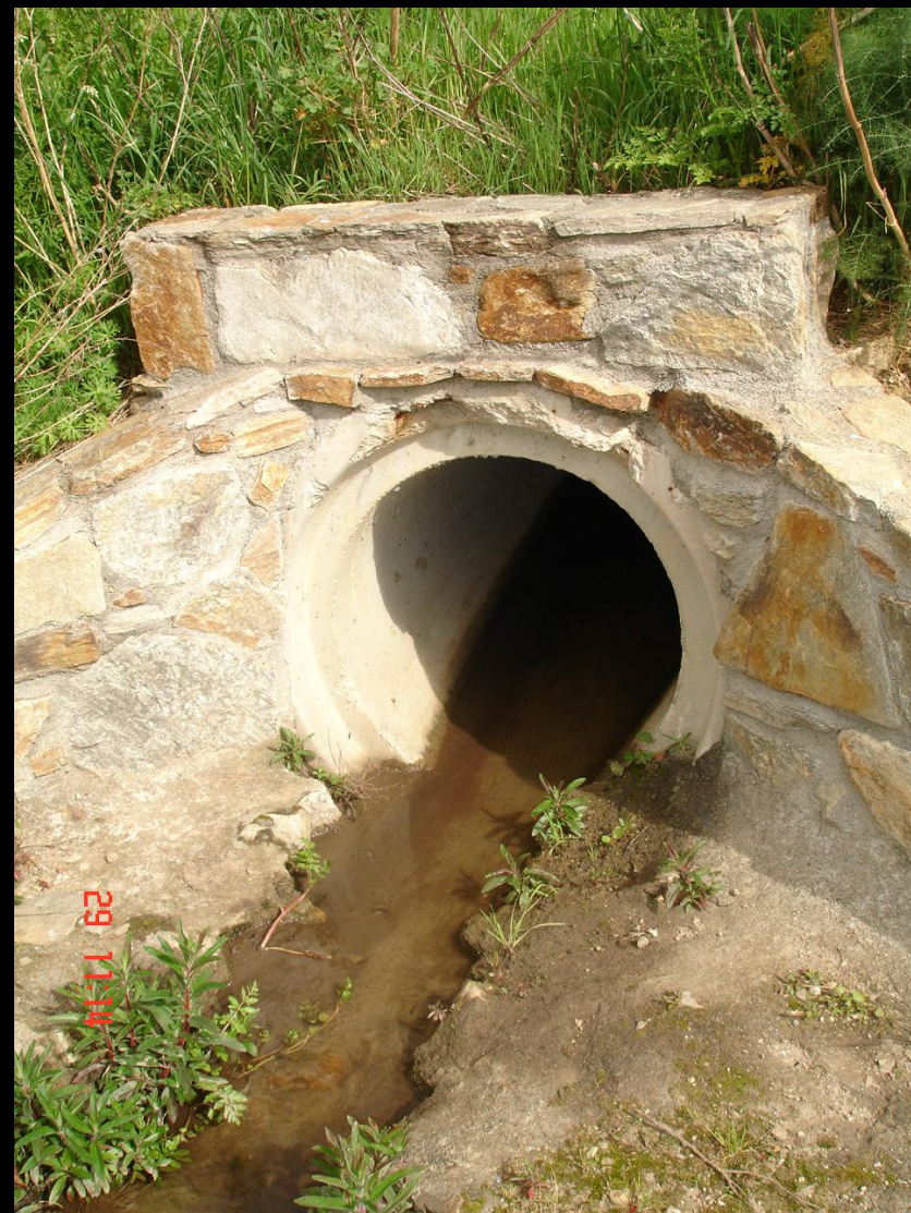
Aportación de caudal
