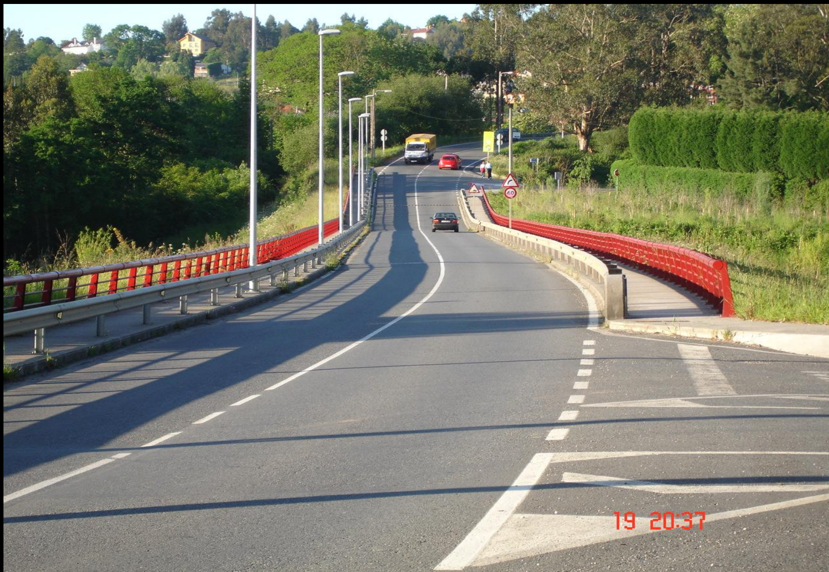
Puente de acceso a Cambre
