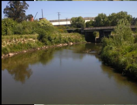
Vista general del tramo
