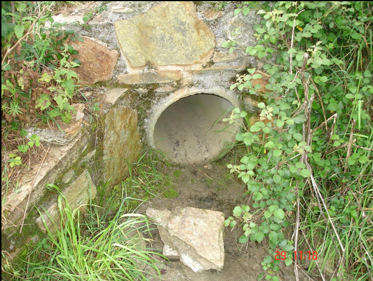
Obra de drenaje transversal
