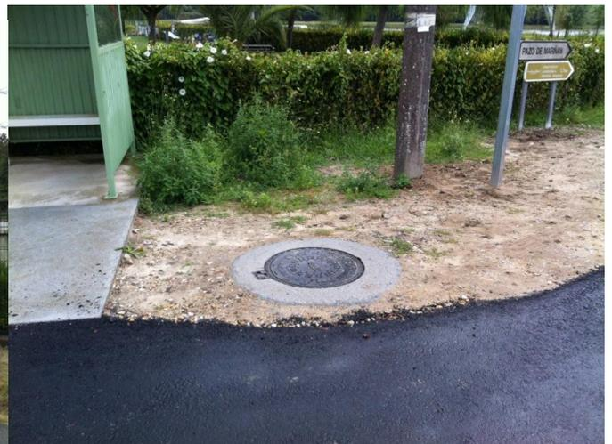
Figura 37: Pozo de registro con suelo pavimentado
