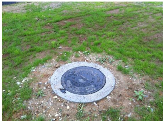
Figura 55: Pozo de registro finalizado, cerca del pozo de bombeo
