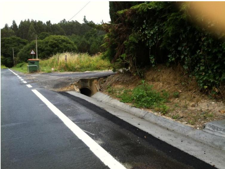
Figura 52: Tramo final con cunetas finalizadas y carretera pavimentada
