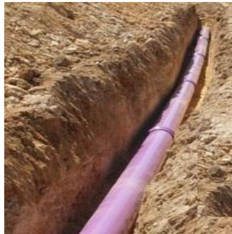
Figura 53: Colocación de tubería en zanja
