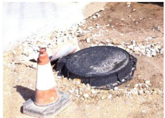
Figura 13: Pozo de registro sin pavimentar
