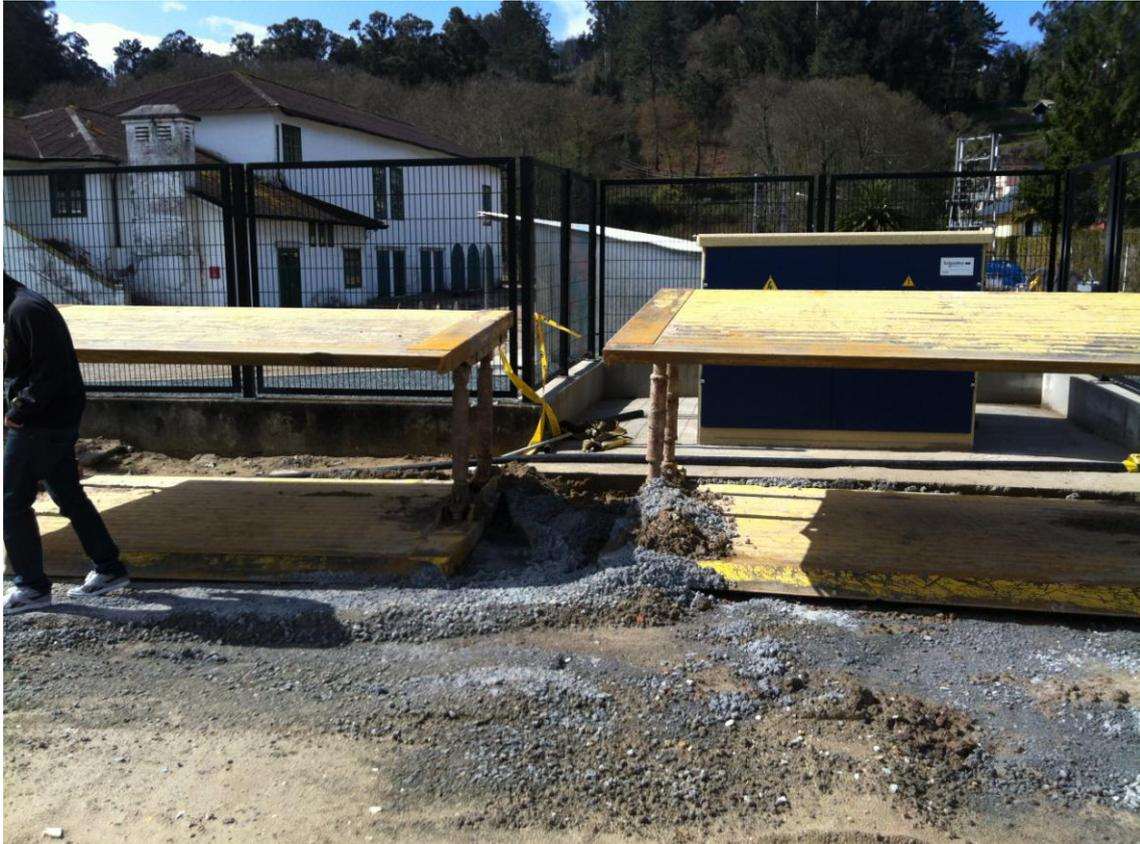
Figura 5: Entibaciones a pie de la subestación eléctrica
