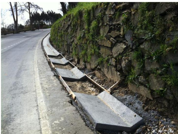
Figura 10: Reposición de cunetas de hormigón
