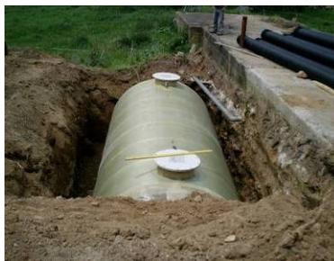
Fosa séptica prefabricada
