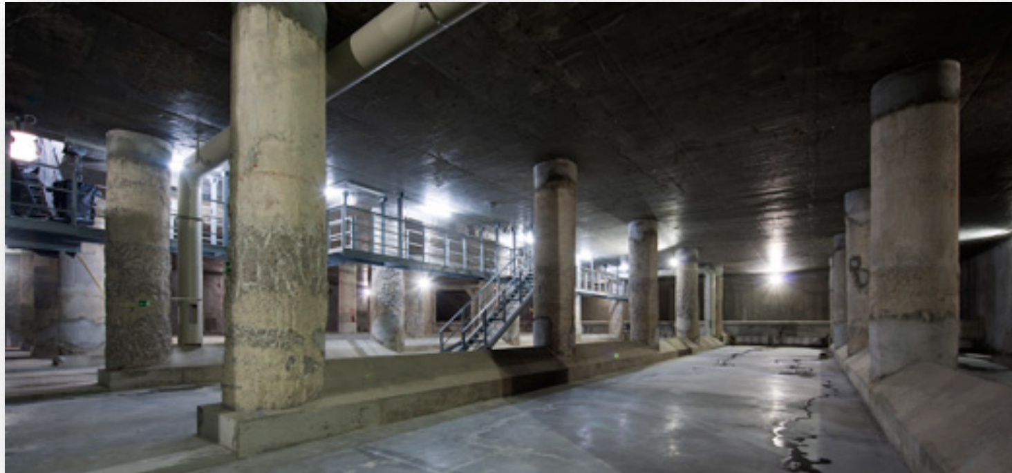
Tanque de Tormentas de Valdemarín, Madrid: Depósito de aguas pluviales de 30.000 m 3 .
