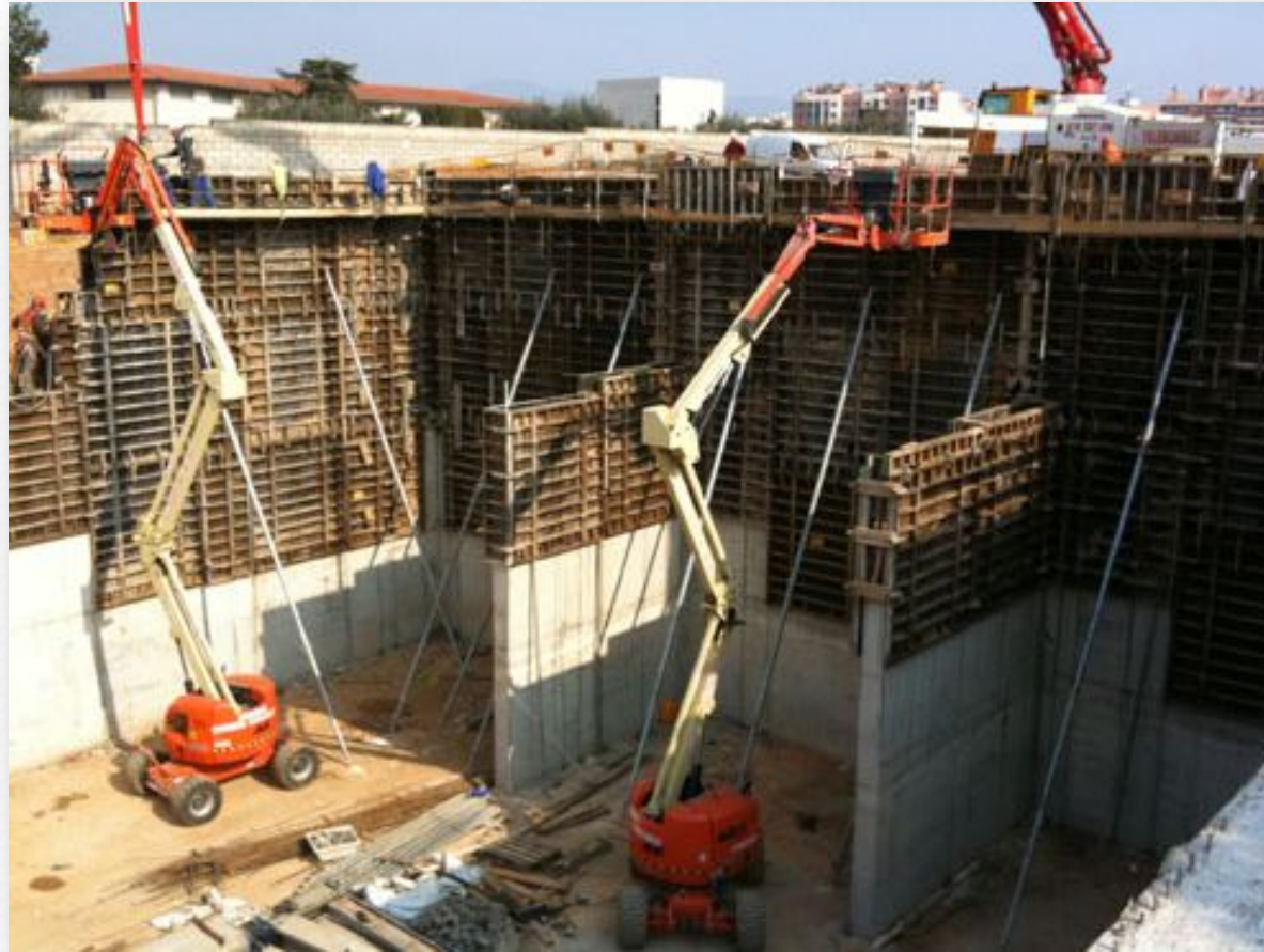
Construcción de depósito de tormentas con encofrado metálico trepado para ejecutar muros a 10 m. de altura.
