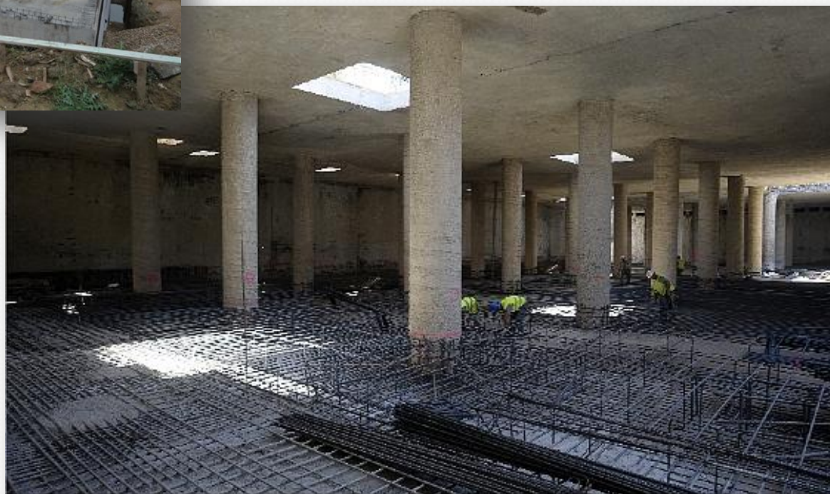
Construcción de Depósito para tormentas en Valencia.
