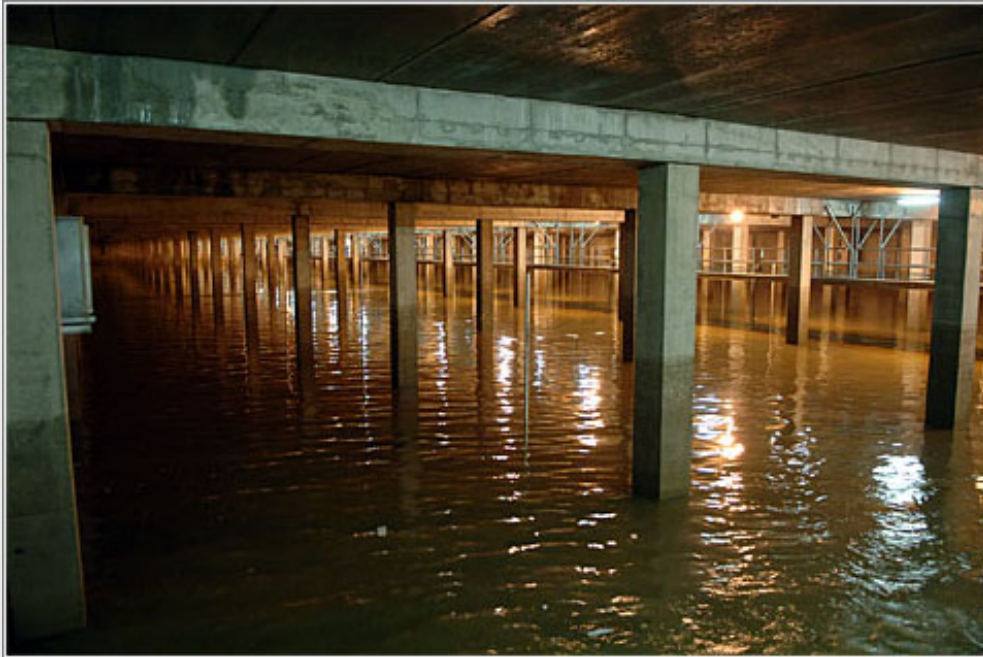
Tanque de Tormentas de Pozuelo de Alarcón (mide 150 metros de largo por 60 de ancho y más de 5 de altura).
