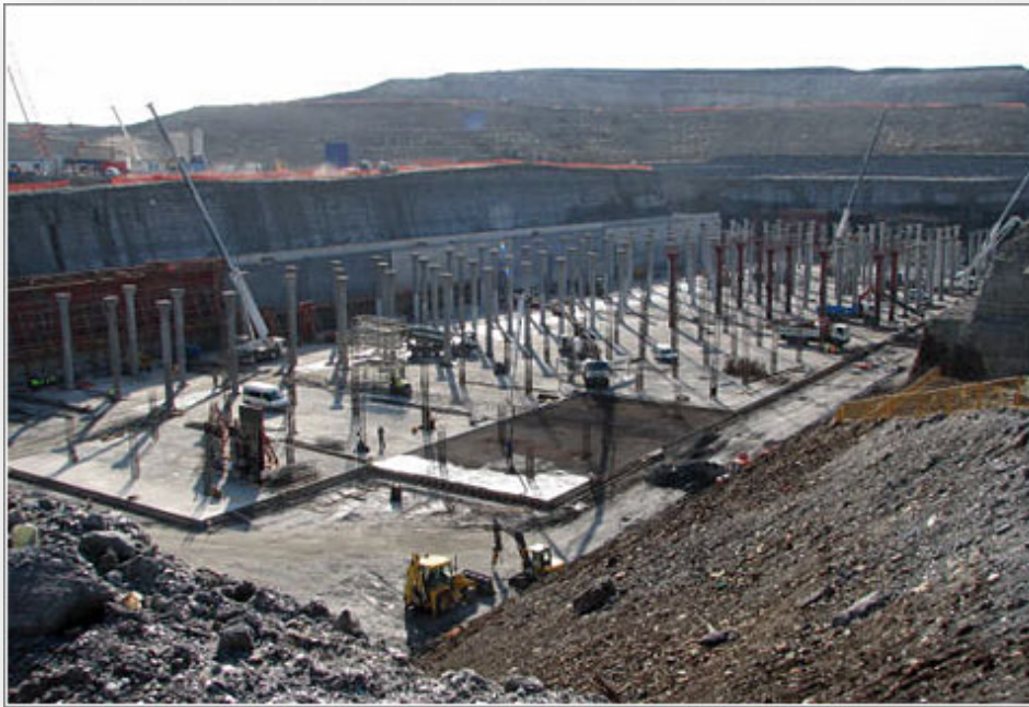
Fotografía de la construcción del tanque de tormentas Abroñigales (Madrid).
